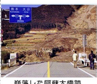
崩落した阿蘇大橋跡
