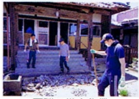
瓦礫の撤去作業
